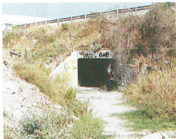
Φωτ. 3. Οχετός παρακαμπτήριου Λεωφόρου Λεμεσού. Βορειοδυτικά γέφυρας επί οδού Στ. Κυριακίδη. Διαστάσεις (2,20 x 2,50 μ.).
