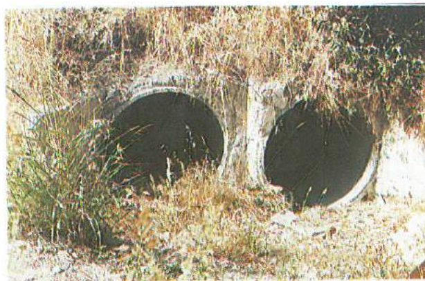
Φωτ. 4. Κλειστός οχετός 2Φ 1,00m. Νοτιοδυτικά της γέφυρας επί της οδού Στέλιου Κυριακίδη.
