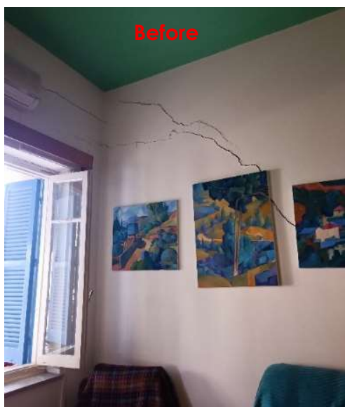
Εικόνα 3: Επισκευή ρηγματώσεων σε φέρουσα τοιχοποιία
