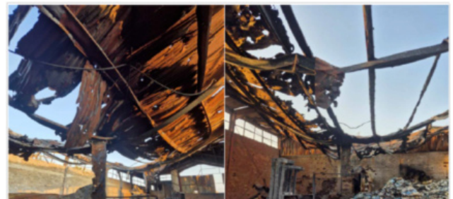
Εικόνα 11: Πλήρης τήξη και καταστροφή δομικών μελών και μεταλλικών φύλλων επικάλυψης της οροφής
