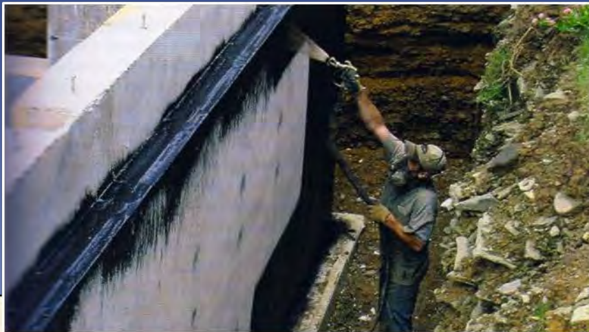
Διάστρωση με επάλειψη ή με ψεκασμό
