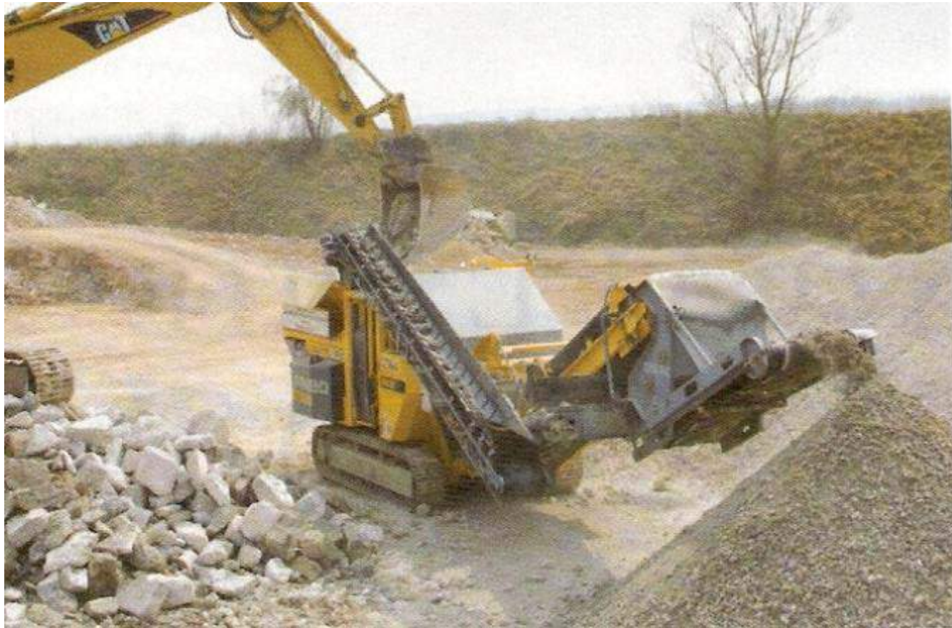
Κινητό μηχάνημα (σπαστήρας & κόσκινα) για την ανακύκλωση σκυροδέματος
