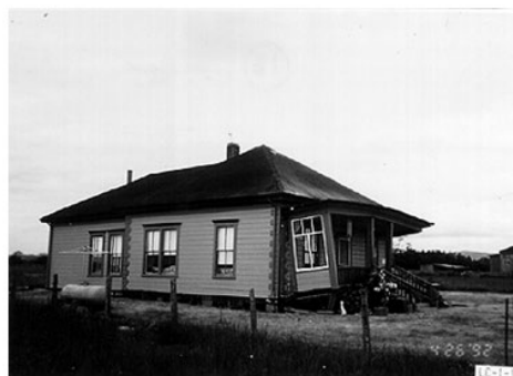
Φωτ. 41: Μονώροφη ξύλινη οικία πλαίσιακού τύπου που ολίσθησε εκτός θεμελίωσης (ΚΟΚΚΙΝΟ)
