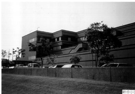
Φωτ. 33: 4ώροφο γαλβδινό κτήριο με εκτεταμένες θραύσεις ναλοπινάκων και αρκετά αντιανέμο μέλη λυγισμένα (ΚΙΤΡΙΝΟ)
