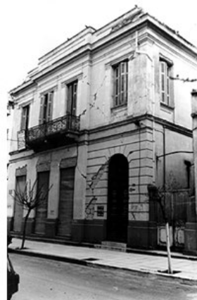
Φωτ. 29: Μέτριες έως σοβαρές βλάβες (ΚΙΤΡΙΝΟ)
