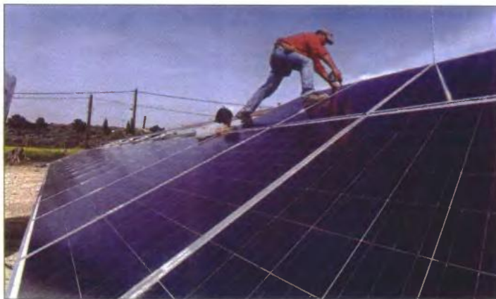
Οι τροποποιήσεις αφορούν τον μετατροπέα τάσης (inverter) και δεν ζητήθηκε να γίνει οποιοσδήποτε τεχνικός έλεγχος ή επέμβαση σε φωτοβολταϊκά συστήματα που εγκαταστάθηκαν μετά τον Οκτώβριο του 2014.
