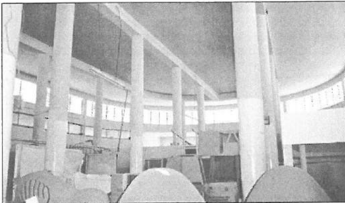
Αποψη του εσωτερικού της Δημοτικής Αγοράς Γεροσκήπου
