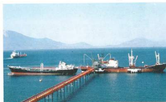
Ειδικά Λιμενικά Έργα
