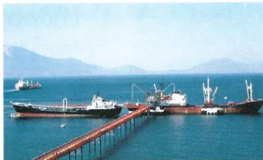
Ειδικά Λιμενικά Έργα
